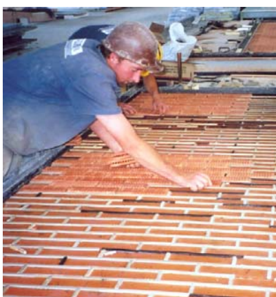
Figura 1 – Colocación de las placas cerámicas
