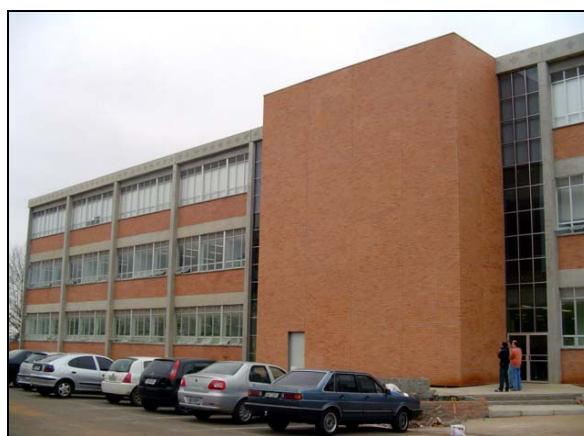
Figura 2 – Edificio con fachadas de GRC con revestimiento cerámico
