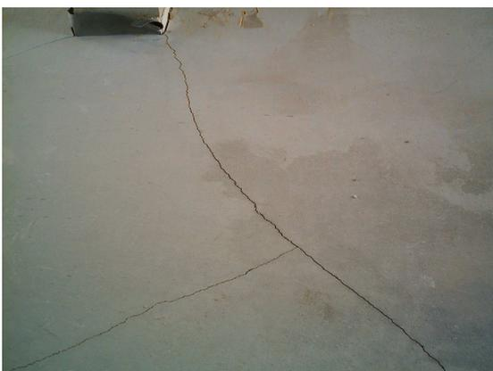
*Fisuración. Ancho de fisura > 3mm*
