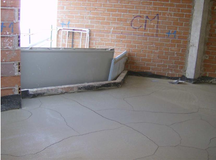
En los casos de fisuras de menor entidad, se opta por el sellado, siguiendo las recomendaciones del fabricante, mediante una lechada de cemento y masilla de poliuretano Sikaflex, penetrando la lechada completamente en la fisura.
