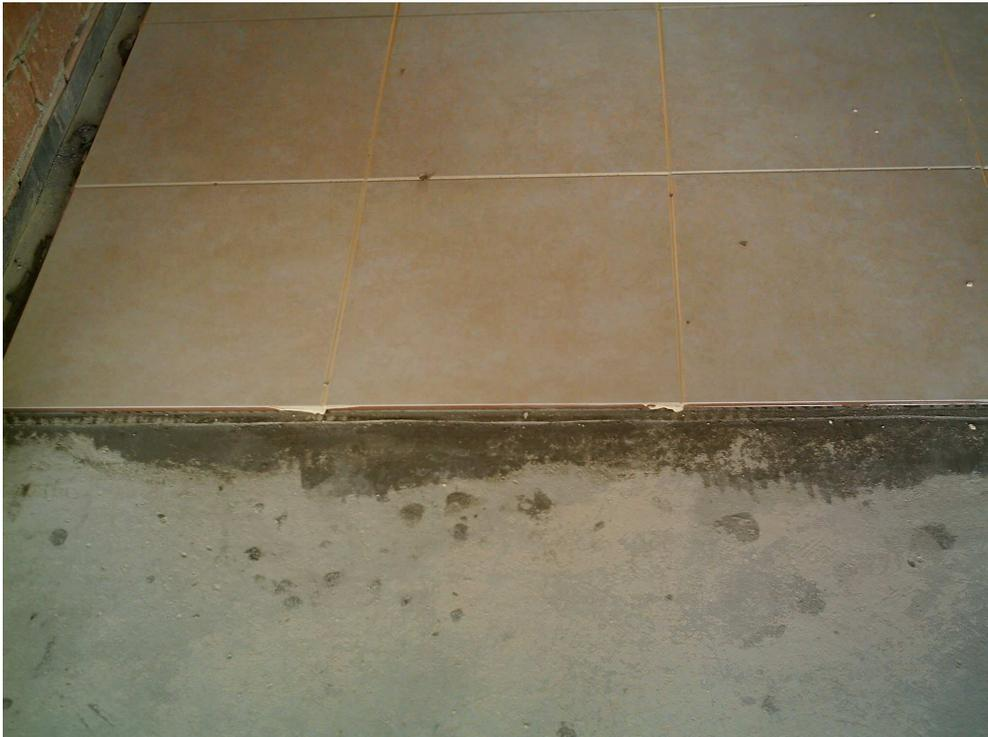
2.4.- Sellado de juntas de movimiento con MAPESIL AC, previa colocación del fondo de junta MAPEFOAM.
