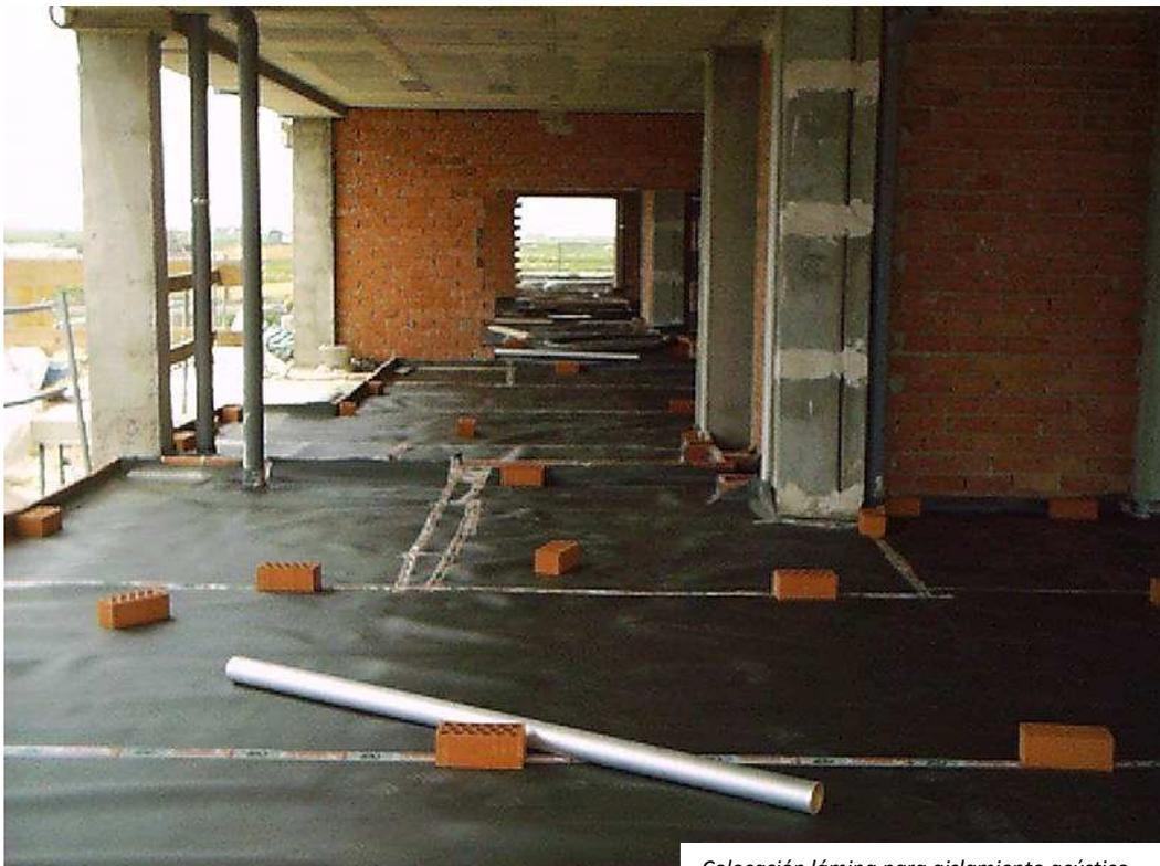
*Colocación lámina para aislamiento acústico*
