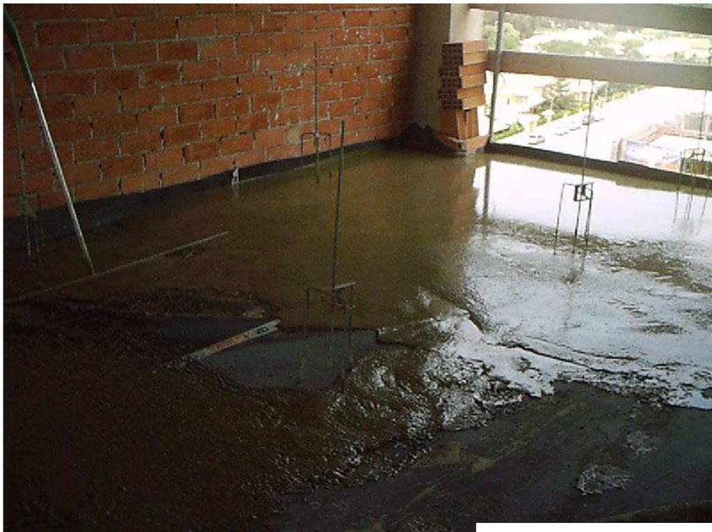
*Vertido del mortero autonivelante*
