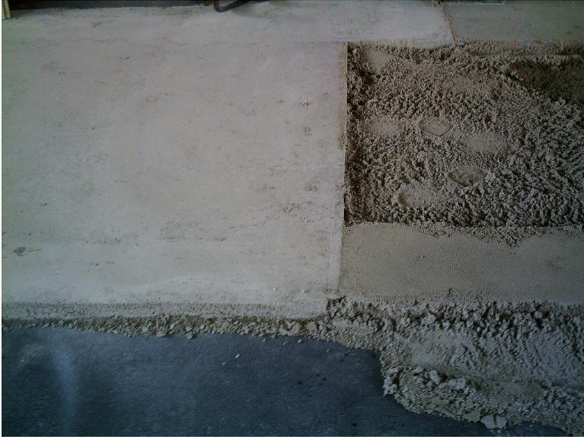
Reparación de la capa de mortero en una vivienda según procedimiento de esta firma comercial mediante el sellado de fisuras con EPORIT y posterior preparación del soporte para la pavimentación y forma de ejecución de ésta última. La prueba de este procedimiento se ha realizado en su totalidad.
